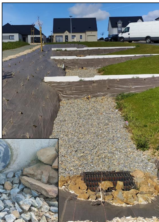
Photo 1 : Vue du bassin d'orage et de l'ouvrage de sortie du lotissement « Les Coteaux »
